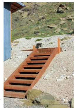
坎入坡道的樓梯
